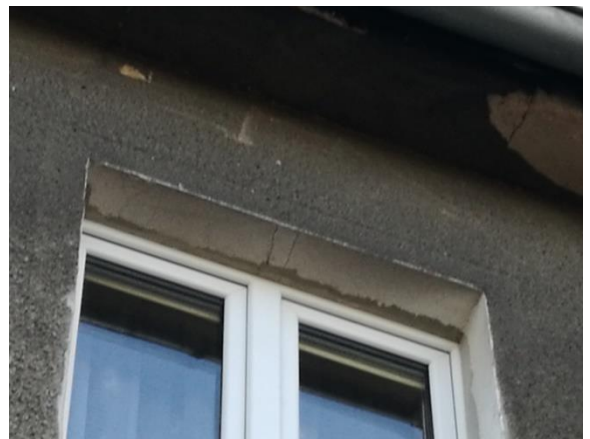
Zdjęcie 27 – Pęknięcia nadproża elewacji na podwórzowej
