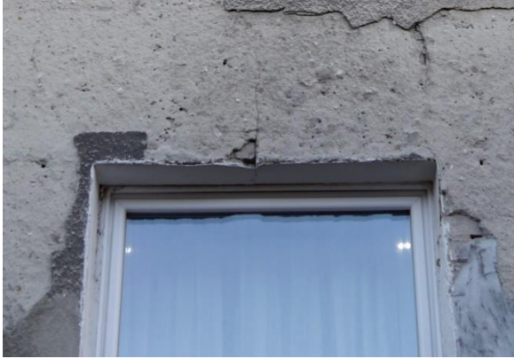
Zdjęcie 20 – Pęknięcie nadproże na elewacji podwórzowej
