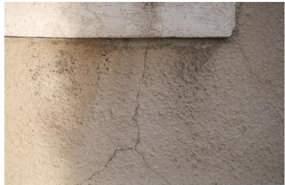
Zdjęcie 11 - Rysa na elewacji frontowej
