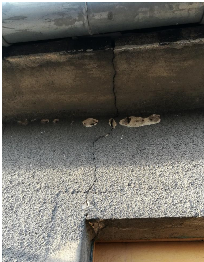
Zdjęcie 12 – pęknięcie nadproża drzwi tarasowych na elewacji wschodniej
