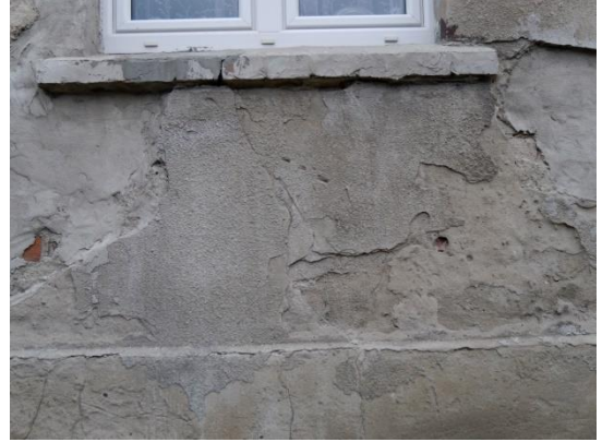
Zdjęcie 21 – Pęknięta ścianka podparapetowa na elewacji podwórzowej i miejscowe naprawy zaprawą cementową
