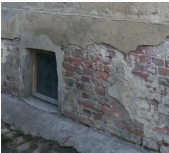
Zdjęcie 7 - Uszkodzenia tynku cokołu elewacji podwórzowej: ubytki tynku, odkryte cegły, wypłukane i zmurzałe spoiny, wykwity soli, widoczne miejscowe naprawy tynkiem cementowym
