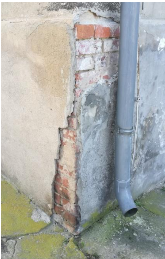
Zdjęcie 9 - Uszkodzenia tynku na cokole północno-wsch. narożnika budynku: znaczne ubytki tynku, tynk odspojony od podłoża na bardzo dużych powierzchniach, mur mokry, zmurzałe spoiny odkrytego muru.
