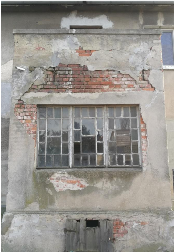
Zdjęcie 24 – Uszkodzenia przedsionka zachodniego
