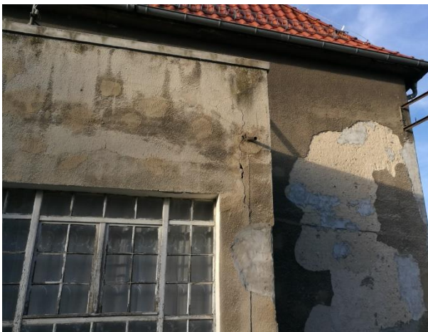
Zdjęcie 26 – Pęknięcia ściany przedsionka wschodniego
