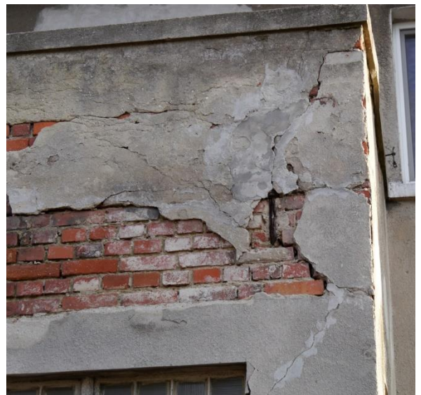
Zdjęcie 23 – pęknięcia ścian przedsionka zachodniego
