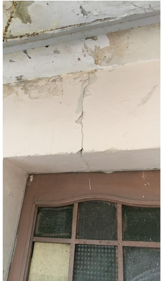
Zdjęcie 25 – Uszkodzone nadproże drzwi wewnętrznych do zachodniej klatki schodowej
