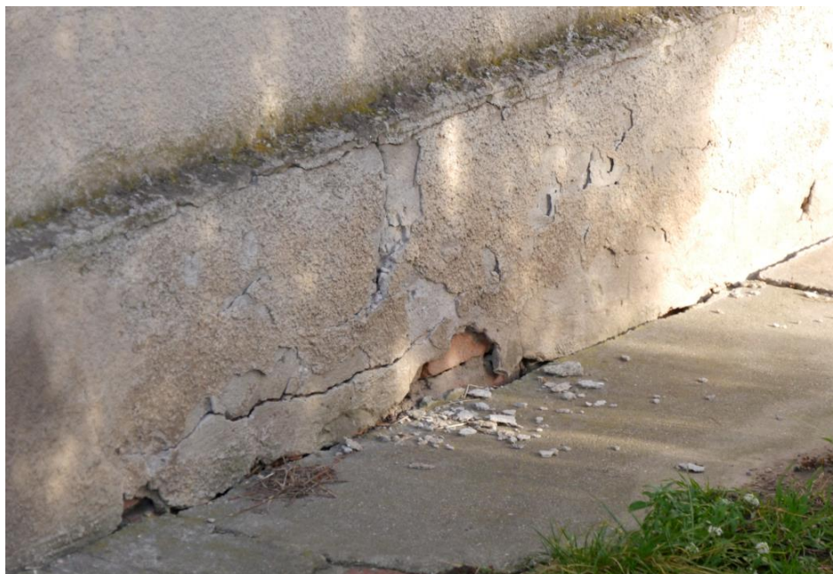
Zdjęcie 8 - Uszkodzenia tynku cokołu elewacji frontowej: skorodowane powłoki malarskie, spękania, wilgotny, skorodowany i odspojony od podłoża tynk, ogniska alg,
