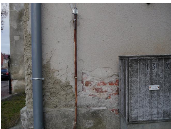
Zdjęcie 18 – Pęknięcie pionowe (połudn.-zach. narożnik elewacji frontowej)
