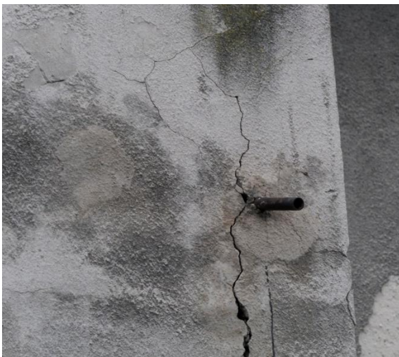
Zdjęcie 22 – Pęknięcie ściany przedsionka wschodniego
