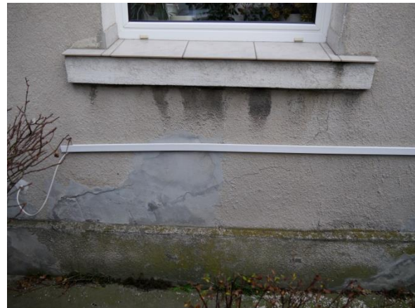
Zdjęcie 11 – naprawa miejscowa pęknięcia ściany podparapetowej
