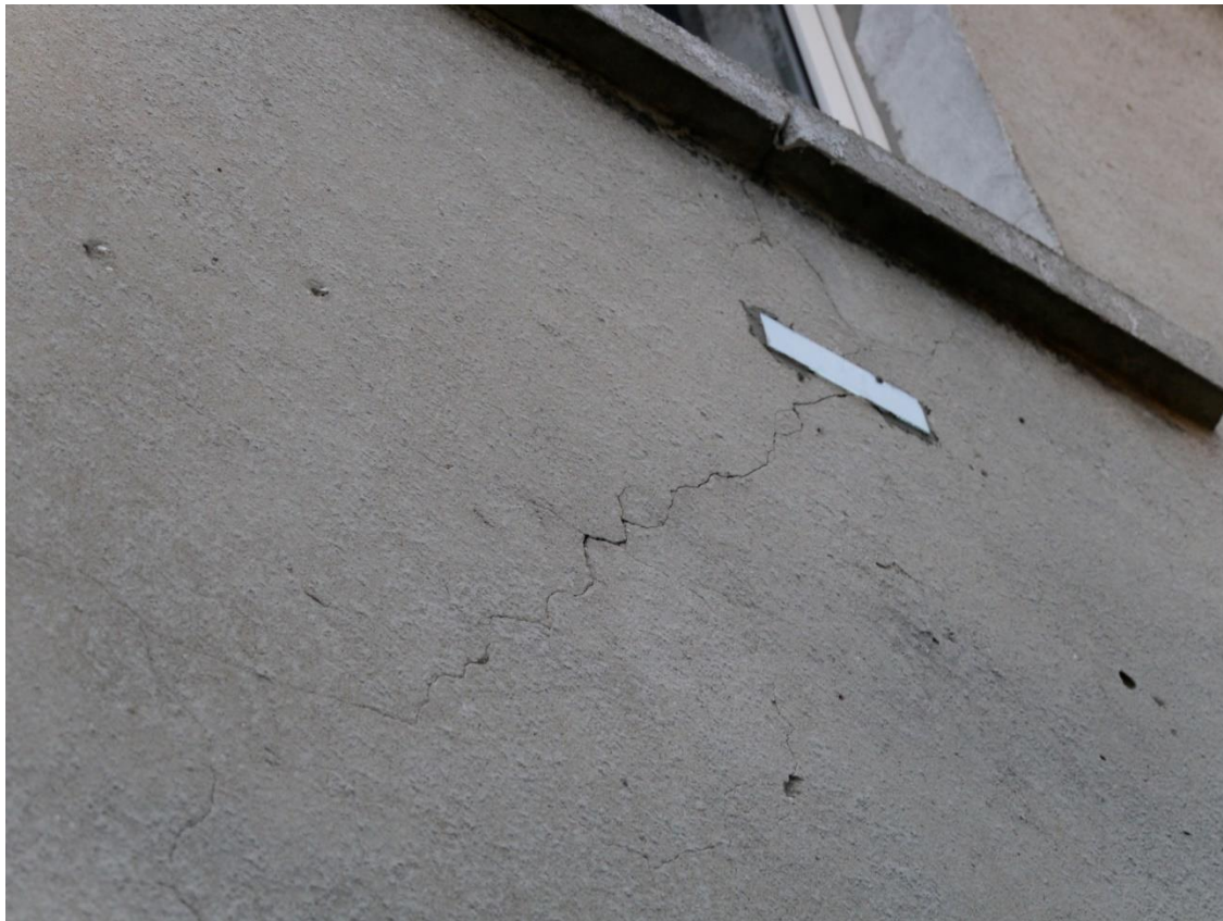
Zdjęcie 17 - Pęknięcie ściany frontowej przy plombie nr 1
